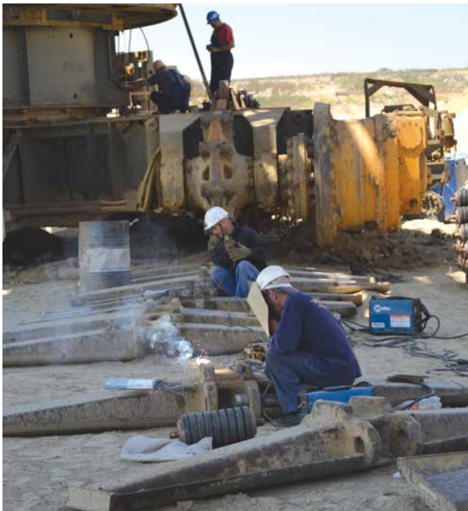
■ Сезона ремонта почиње у марту и трајаће седам месеци
